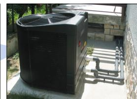
Nel caso la pompa di calore verticale sarà posizionata sotto una tettoia (per la protezione dai maltemp), la tettoia dovrebbe essere almeno 1,5 m sopra la pompa. In caso di pompa orizzontale questo non è rilevante.
